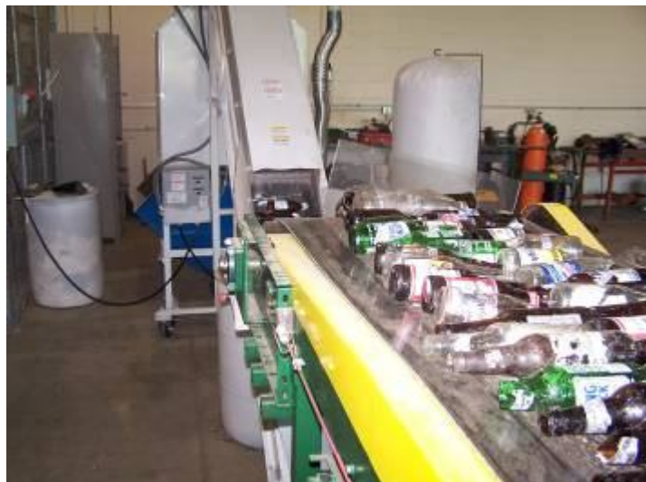
Slika 4.7 Postrojenje za reciklažu stakla
