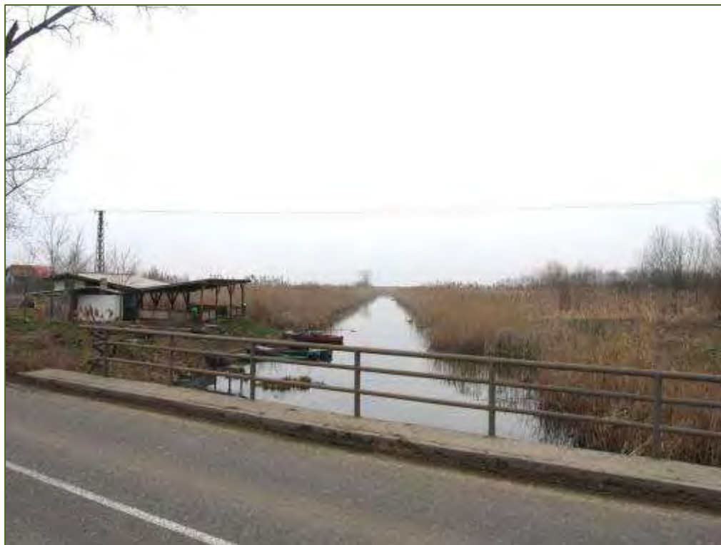
Слика 56: Мост на Јегричкој северно од Темерина
